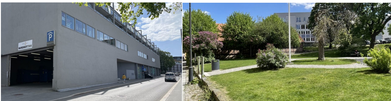
Figur 6-5 Langs Storgata er det store ensidige parkeringshusfasader, men delområdet har også frodige parker slik som Heilmannsparken.
