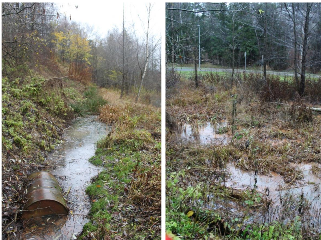
Bilde 2, til venstre. Viser avskjæringsgrøften ved deponiflanken, og avfall.
