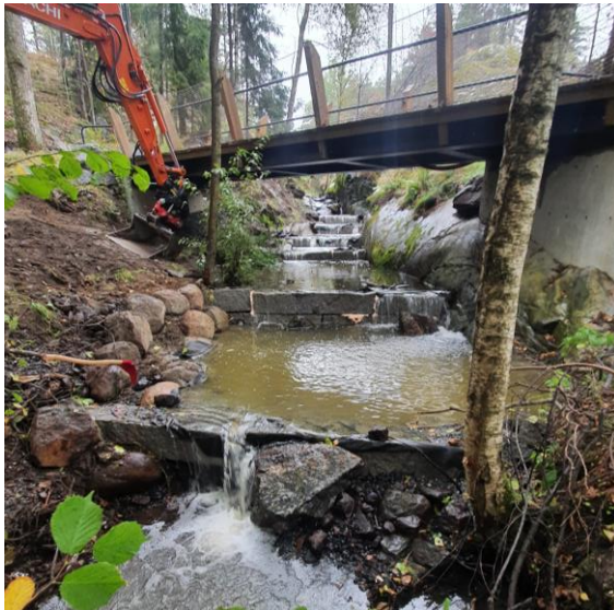
Figur 18 Trolldalsfossen, bilde er tatt under arbeidet med fisketrappen.
