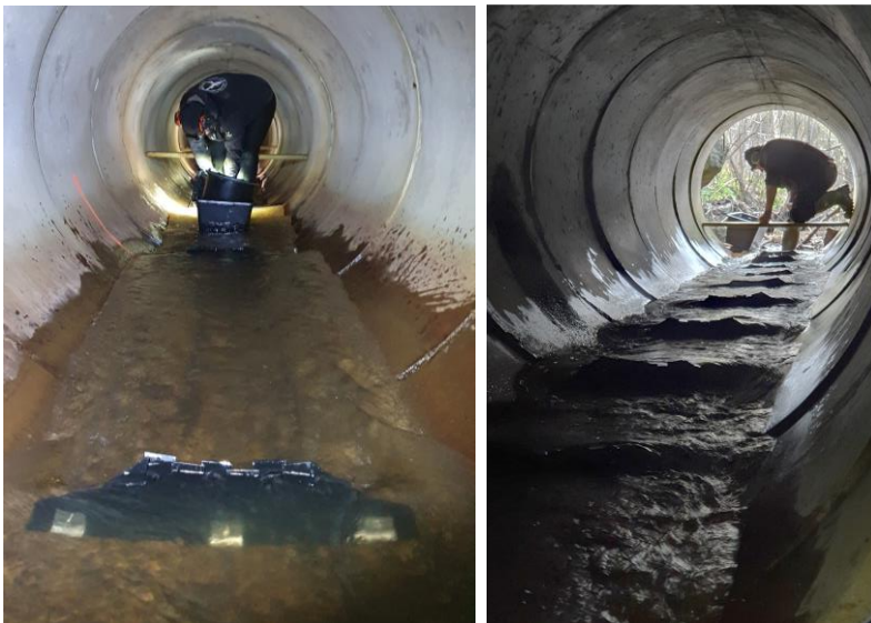
Figur 12 Montering av fiske Baffels og sammen med Skjærgårdstjenesten i kulverten under Osloveien
