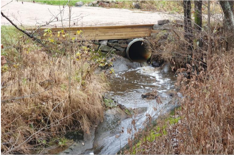
Figur 13 Kulverten ved Mosseveien 201
