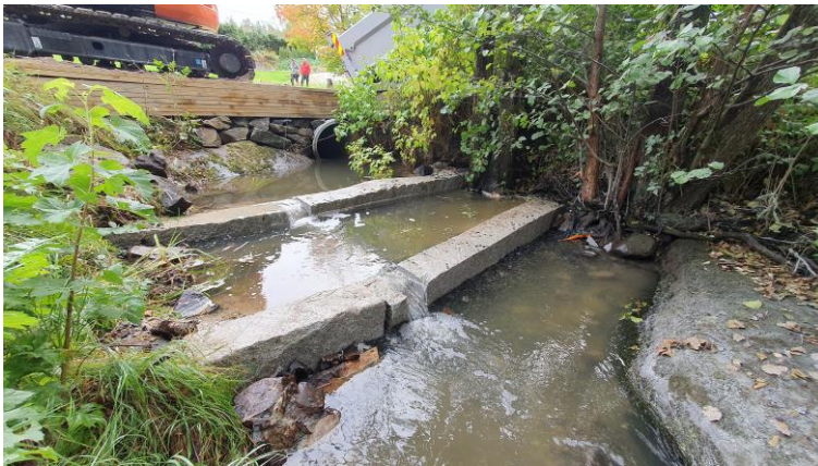
Figur 14 Granittterskler for å hente opp vannhøyde.
