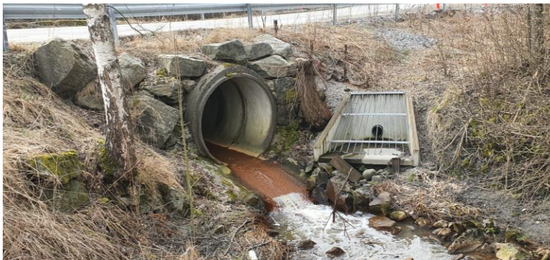
Figur 8 Kulvert før tiltak
