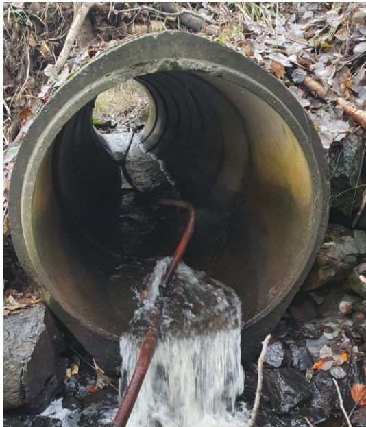
Figur 16 Siste kulvert som skal byttes ut med bro
