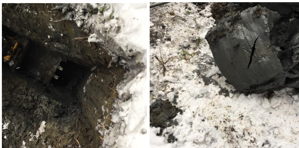
Figur 5: Bilder av prøvegravingen. Til venstre sees grabben nede i prøvegraven. Til høyre ser man typisk leire som hadde tendens til å sprekke opp, som tyder på høyt vanninnhold.
